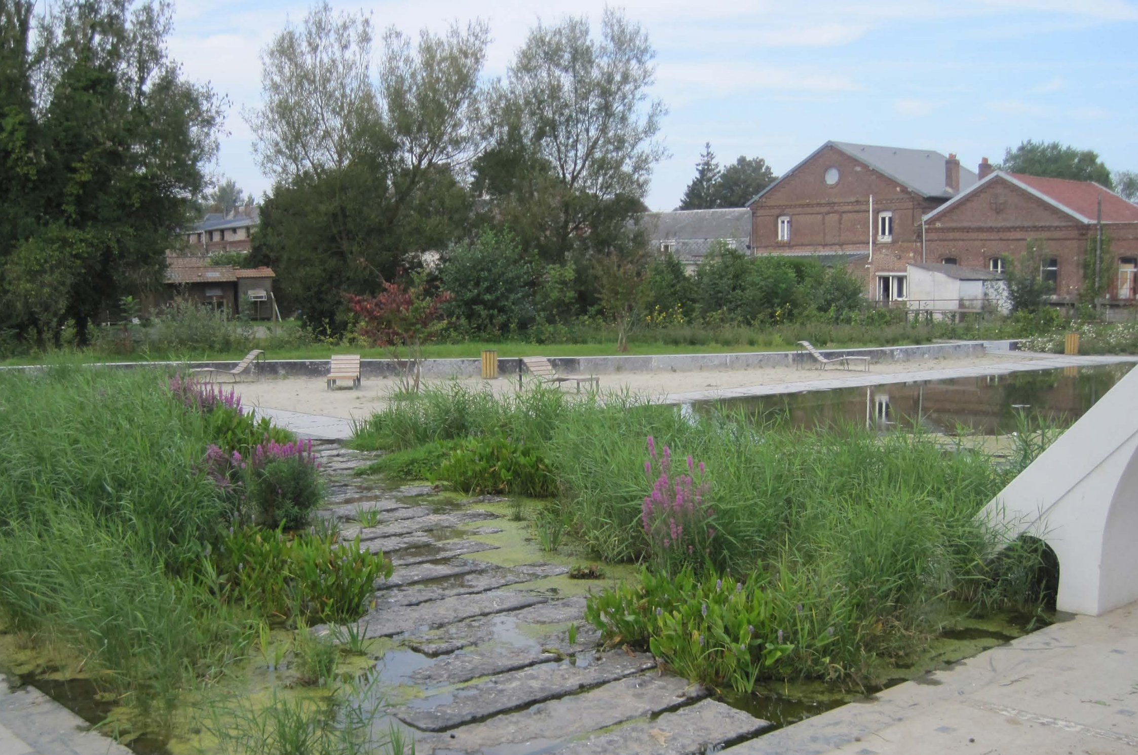
LE CATEAU CAMBRESIS - aménagement du stade nautique et du parc Thuru - 2014 - AMO - 1.000.000 € H.T.
